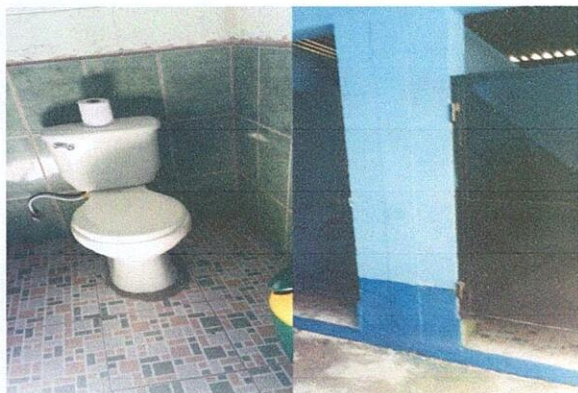
Foto1: finalización, cambio de sanitarios, pintura de puertas y paredes.
