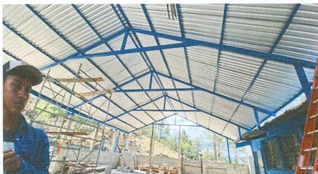
Foto4: Techado y enlaminado de la cancha.
